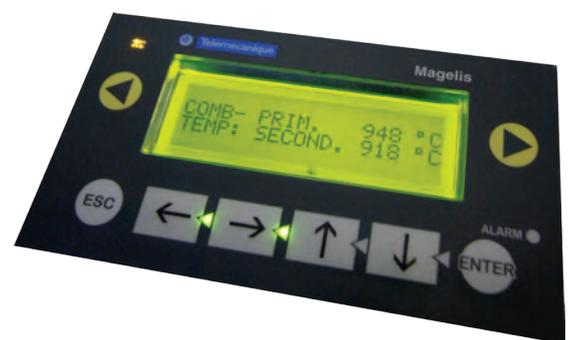
PLC面板顯示焚化爐對油泥燃燒過程的監控
